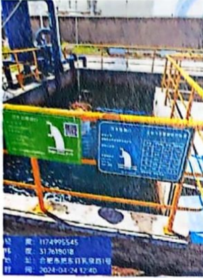
污水总排放口
